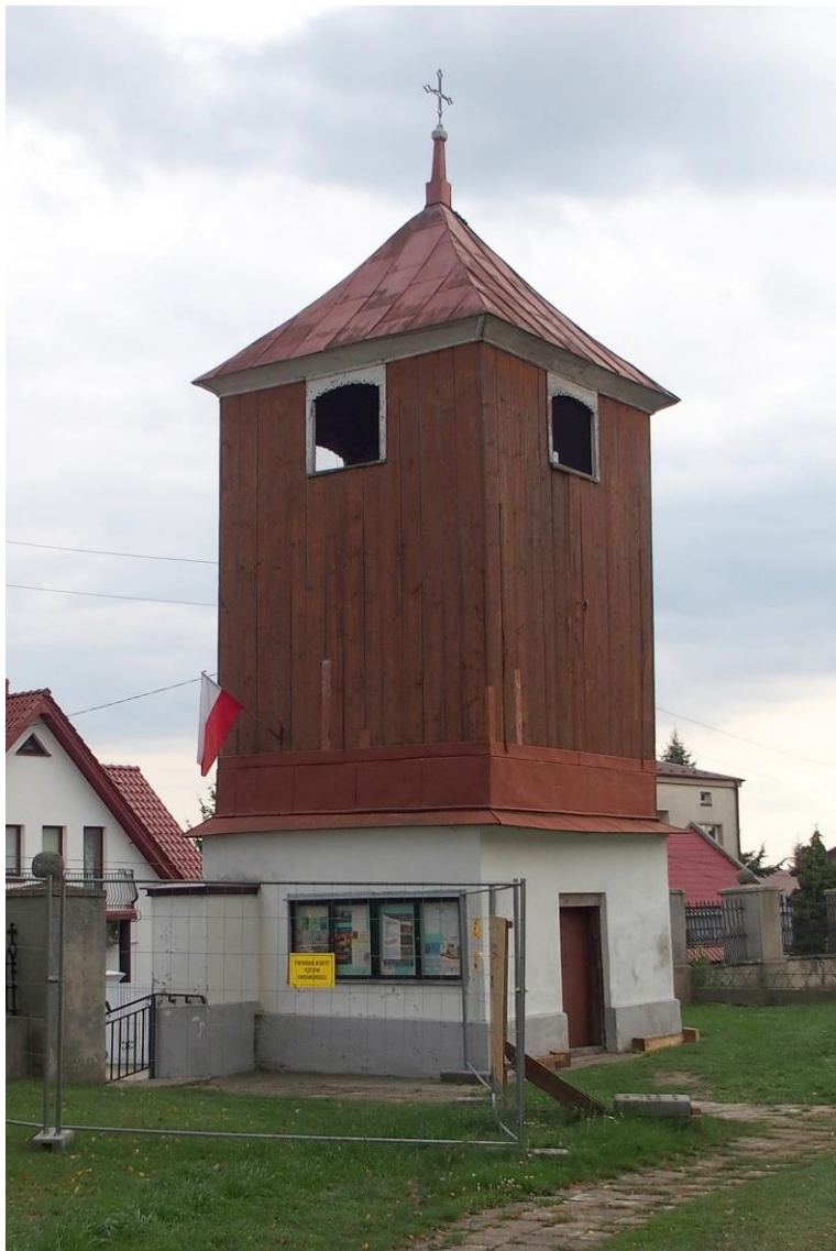
Widok od północnego-zachodu
