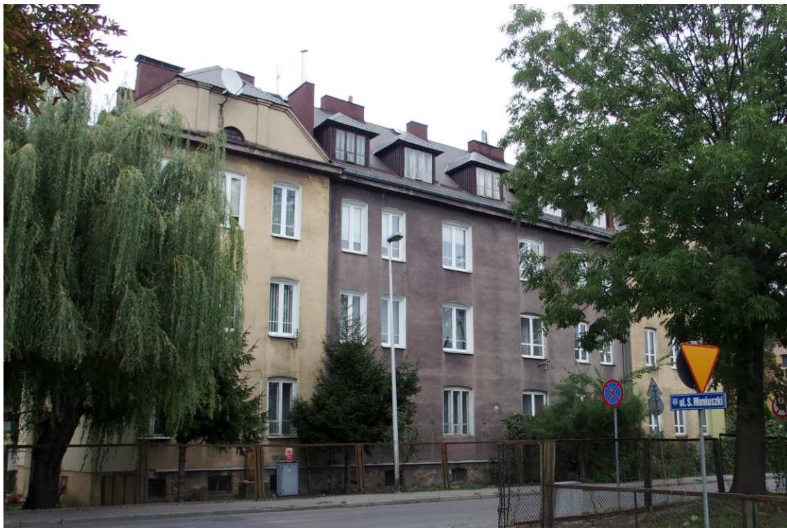
Widok budynku od południowo-zachodu
