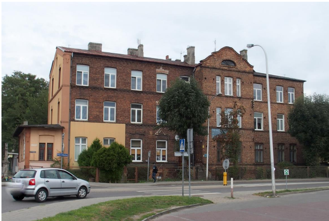
Widok budynku od południowo-zachodu
