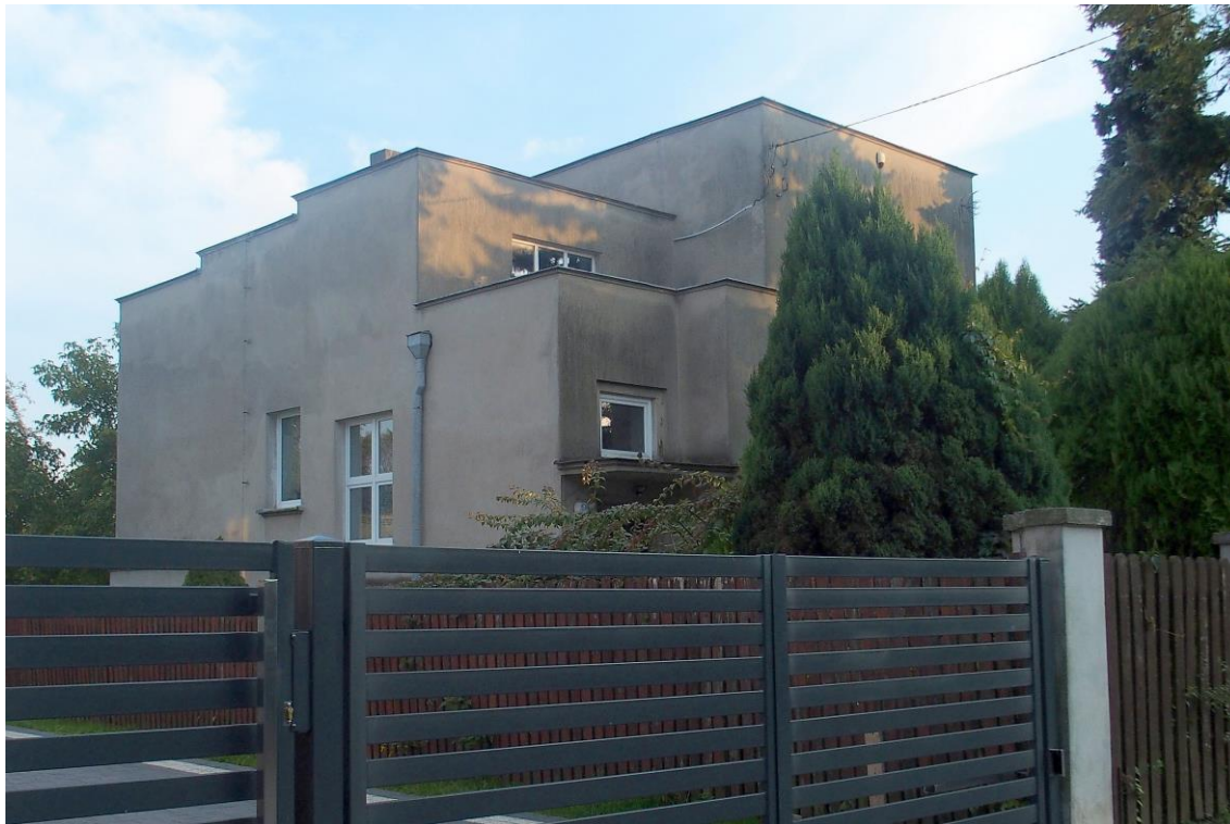
Widok budynku od północno-zachodu
