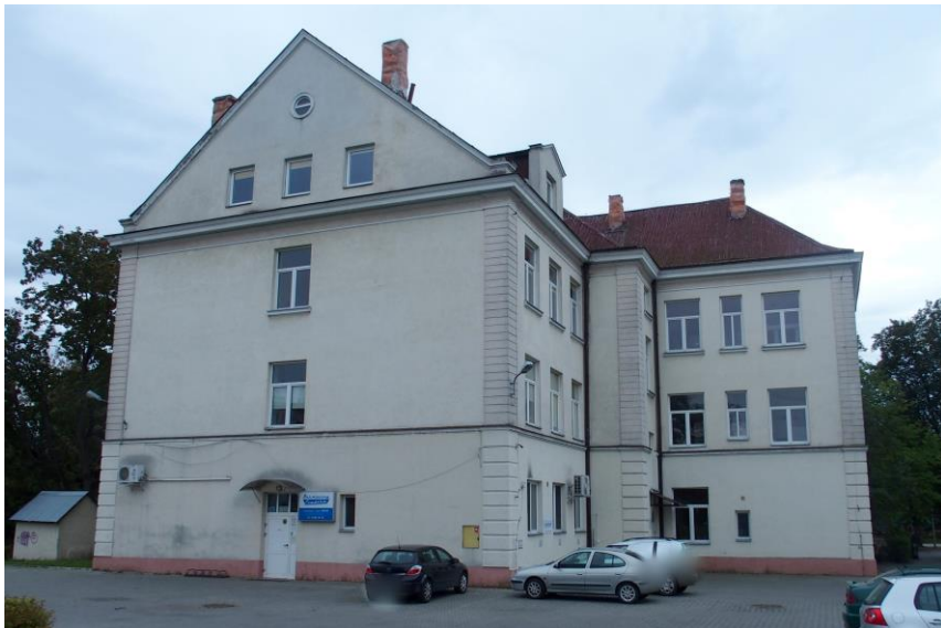
Widok budynku od północy
