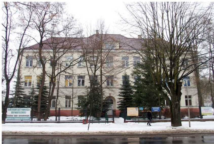
Widok budynku od południowego - zachodu
