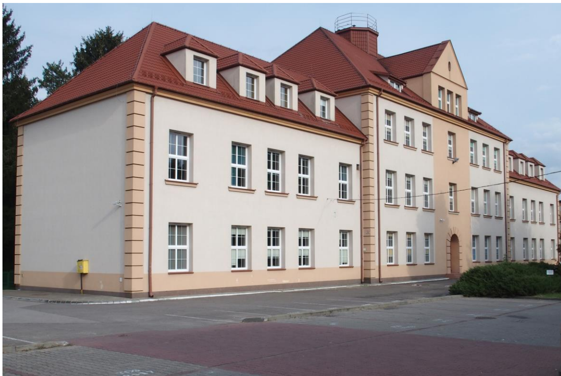
Widok budynku od południowo-zachodu
