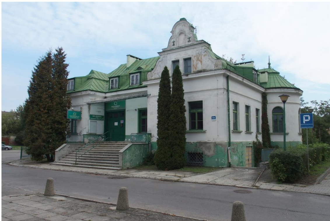
Widok budynku od południowo-zachodu
