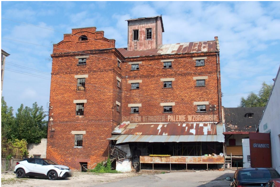
Widok budynku od południowo-zachodu
