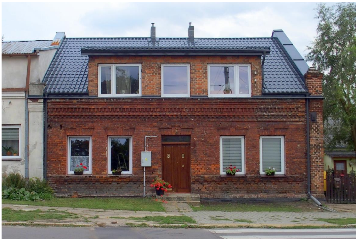
Widok budynku od północno-zachodu
