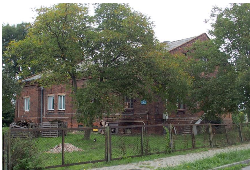
Widok budynku nr 7 od południowego-zachodu
