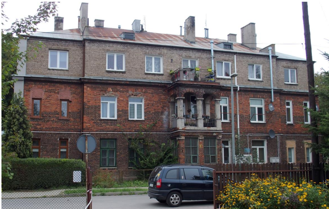
Widok budynku od południowego-zachodu
