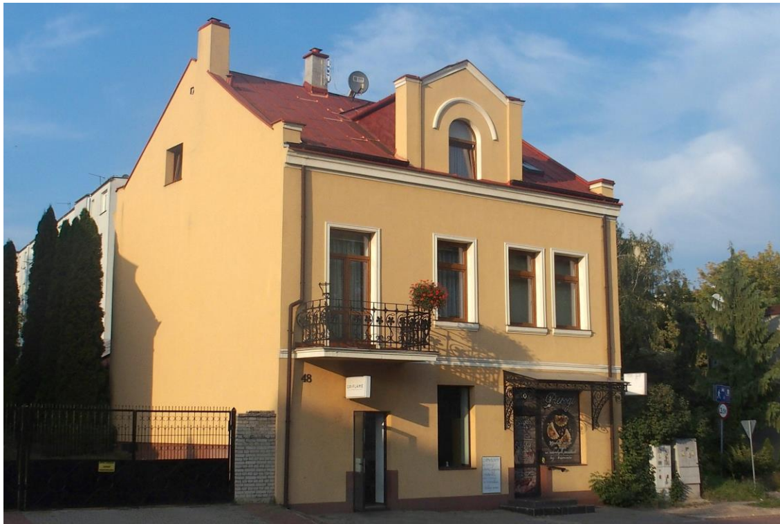
Widok budynku od południowego-zachodu
