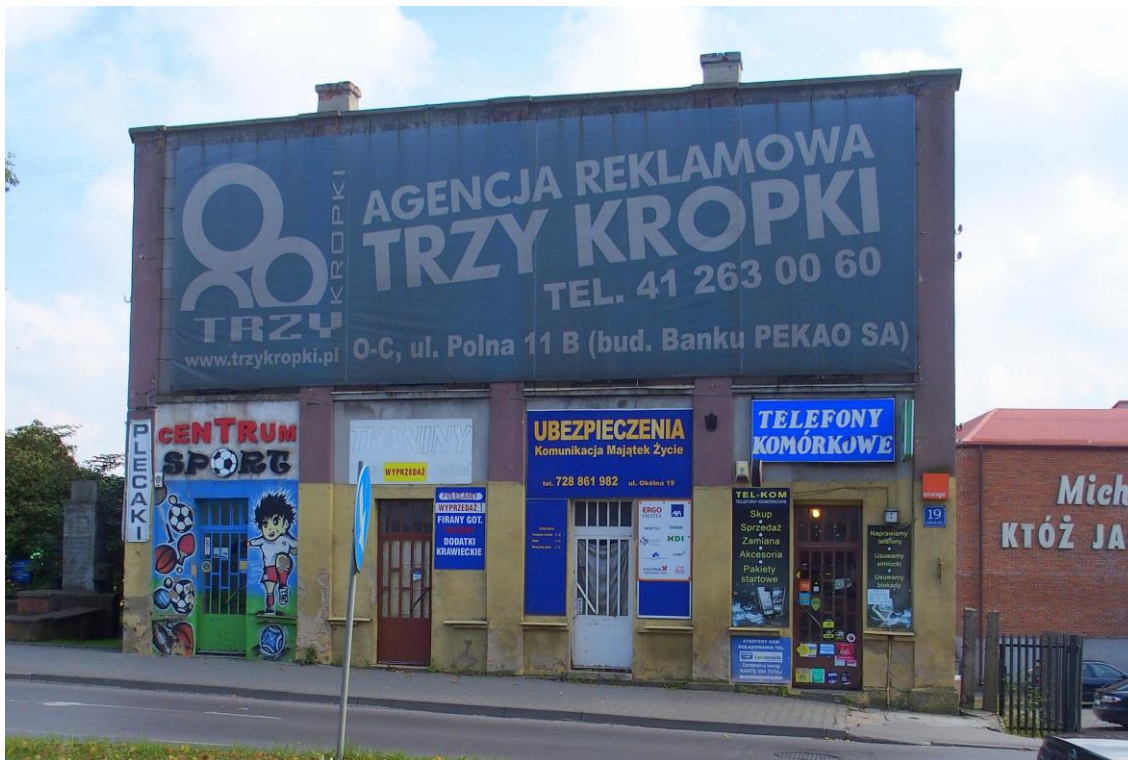
Widok budynku od północno-zachodu
