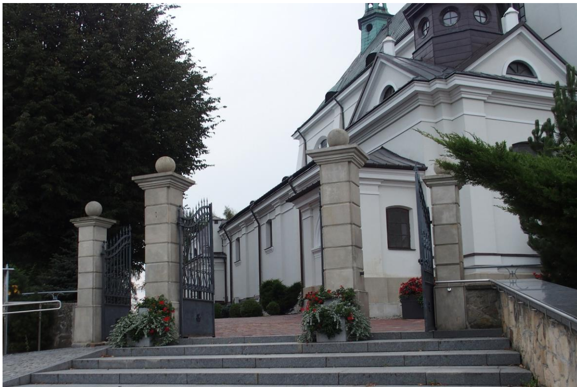
Widok od północnego-zachodu
