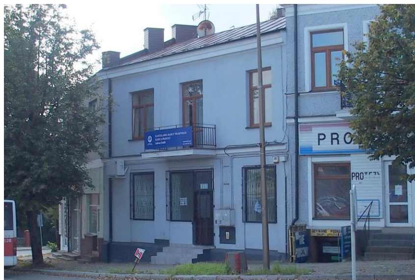
Widok budynku od północnego- wschodu
