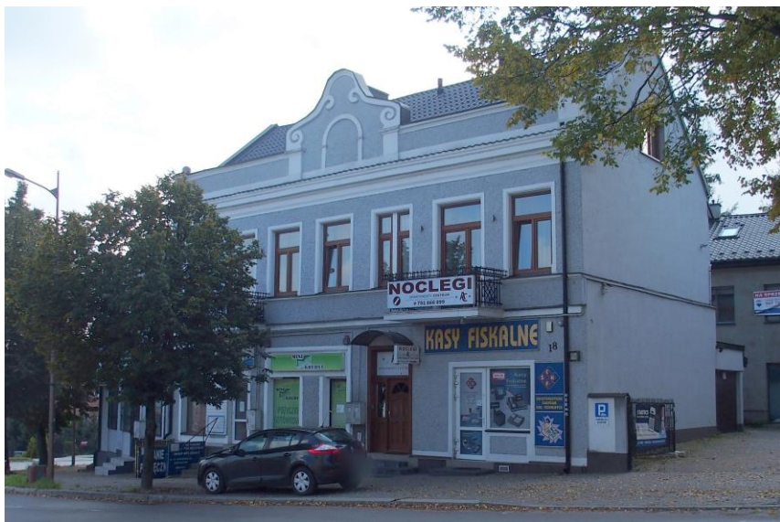
Widok budynku od północy
