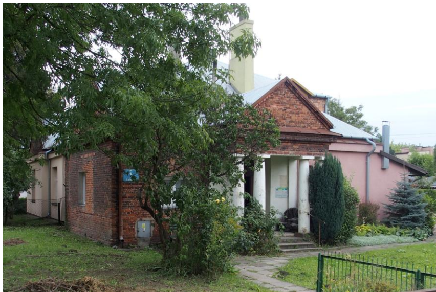
Widok budynku nr 1 od północnego-zachodu
