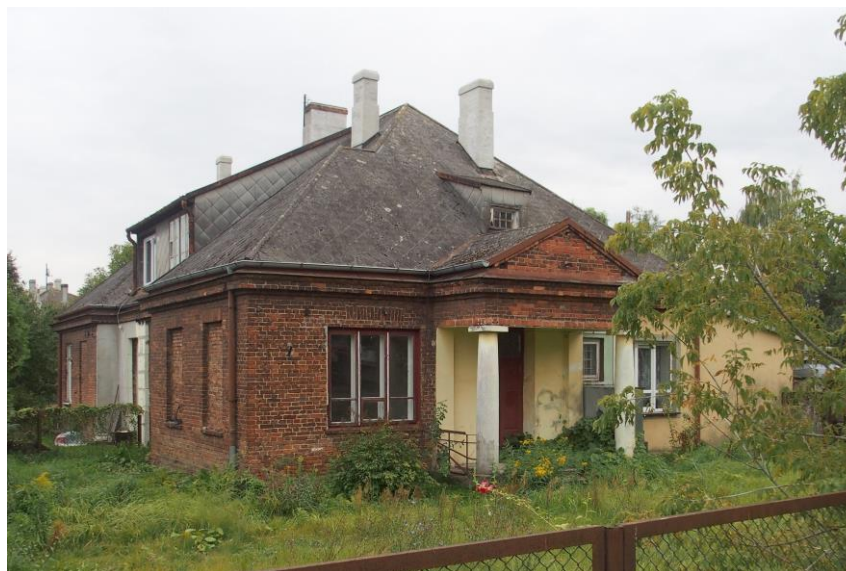
Widok budynku nr 6 od północnego-zachodu
