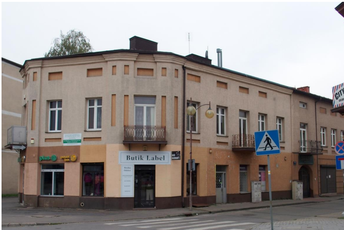
Widok budynku od północno-wschodu
