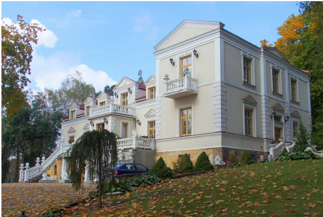
Widok budynku od południowo-wschodu
