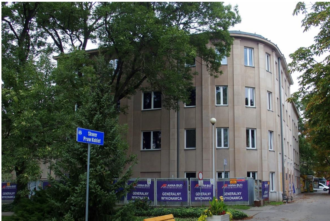
Widok budynku od południowo-wschodu
