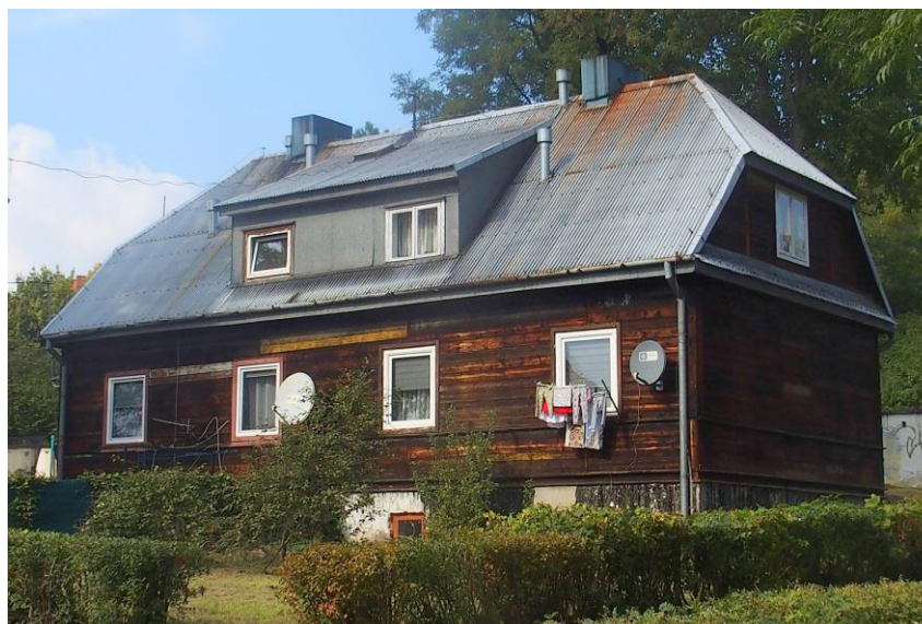
Widok przykładowego „domku” nr 42 od południowego-wschodu
