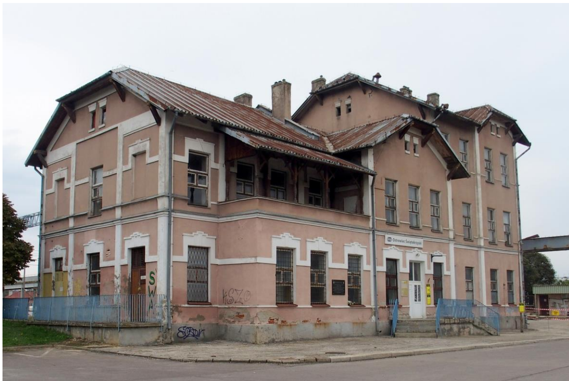
Widok budynku od południowo-zachodu
