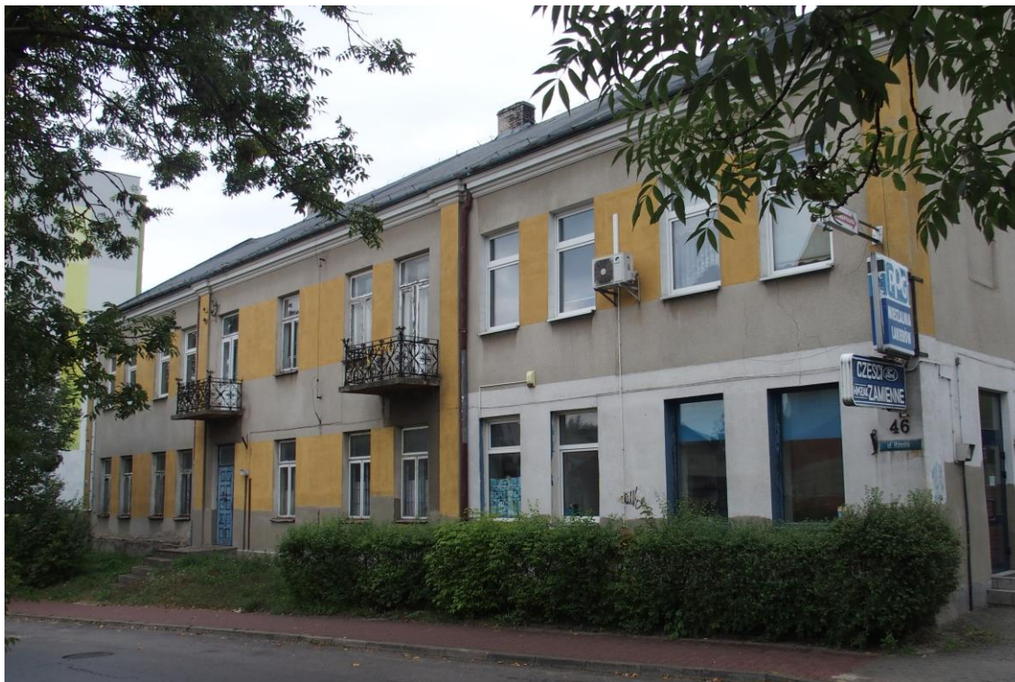
Widok budynku od południowo-zachodu
