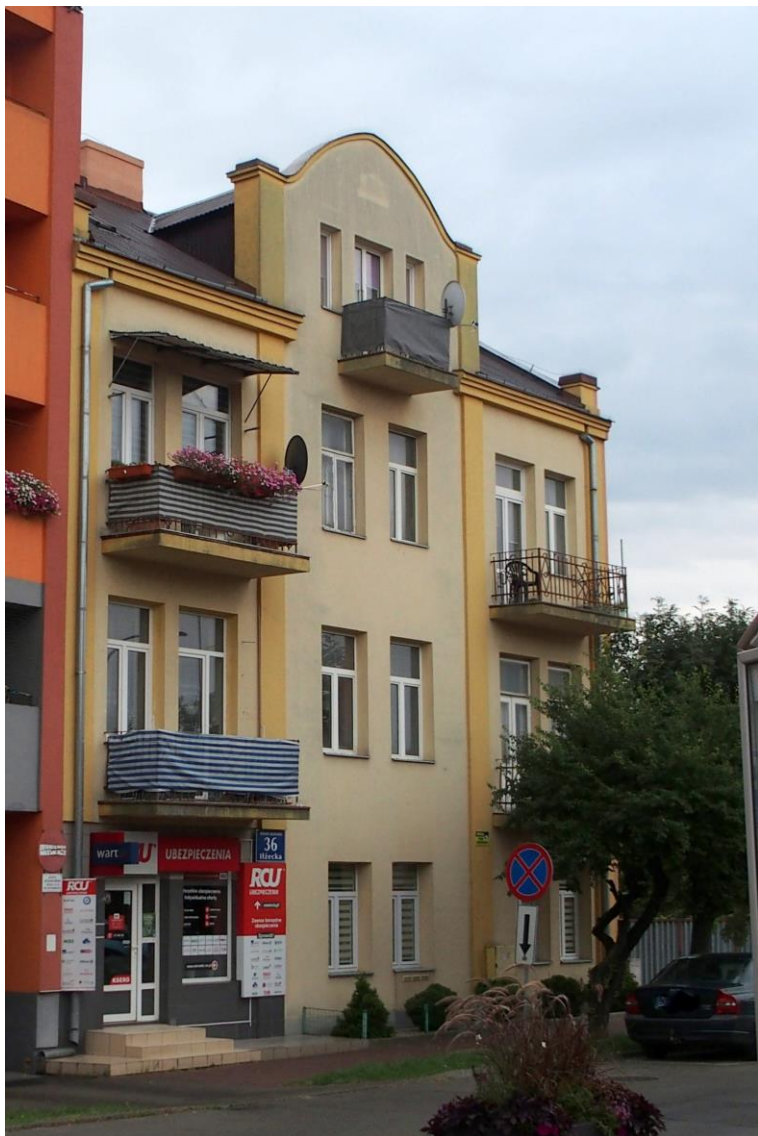
Widok budynku od północnego-zachodu
