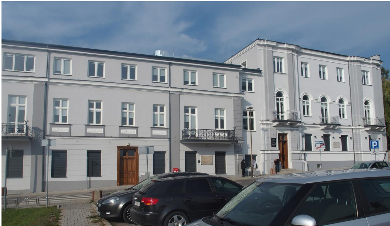
Widok budynku od południa
