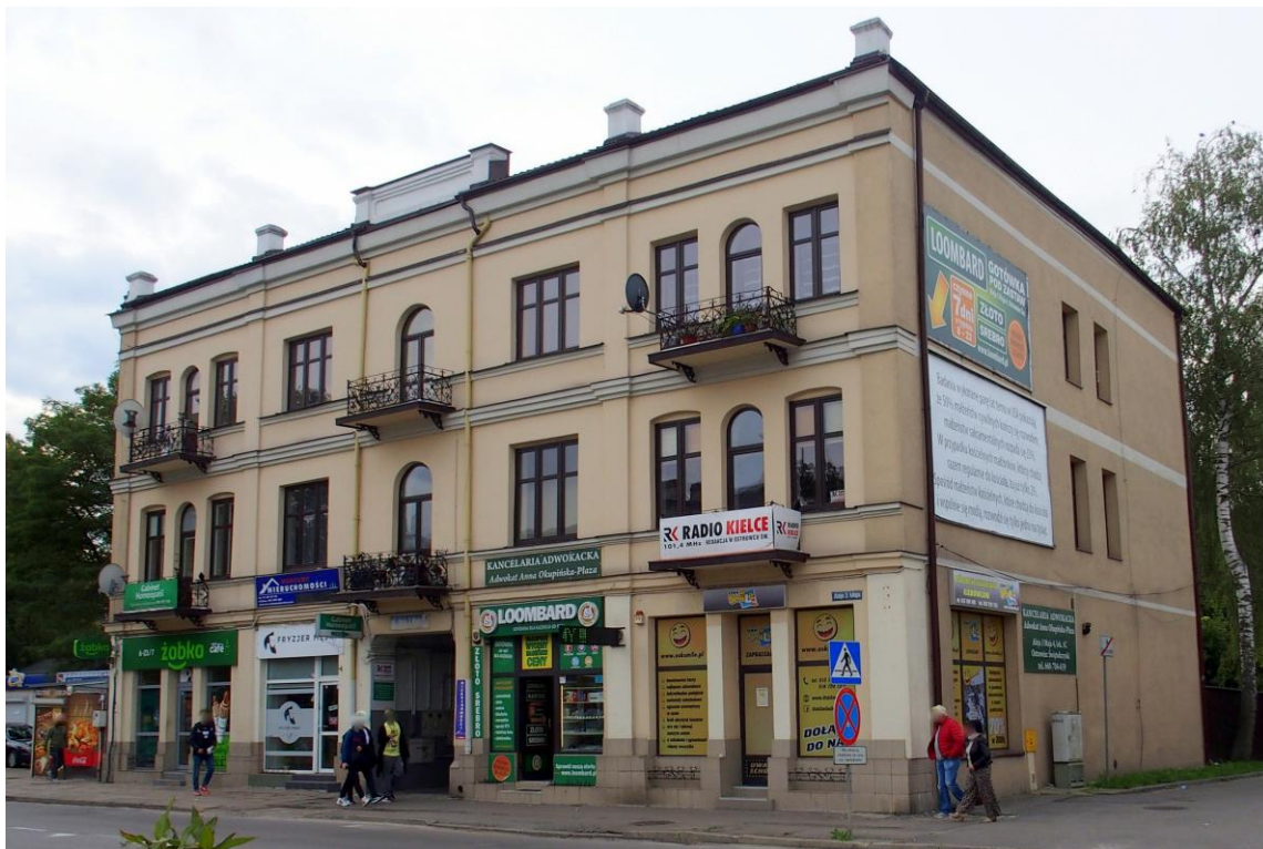
Widok budynku od północno-wschodu
