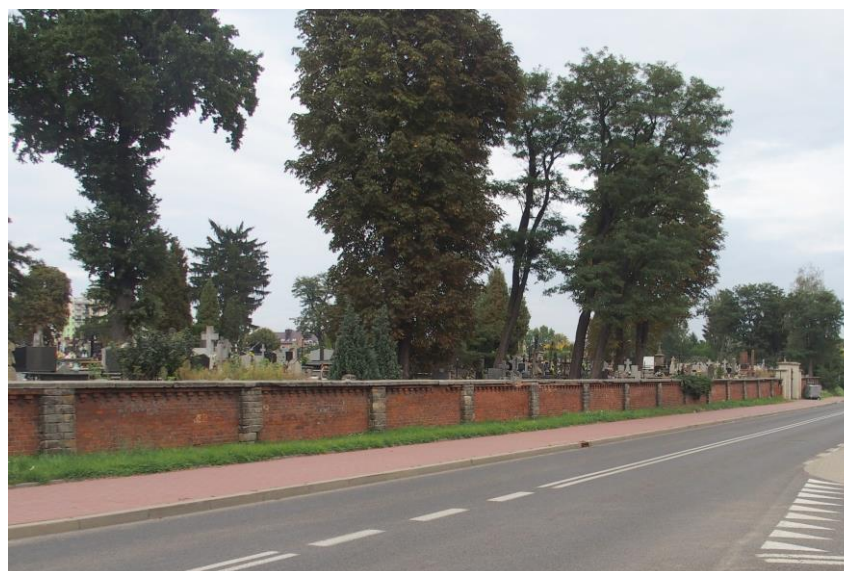
Widok od południowego-zachodu
