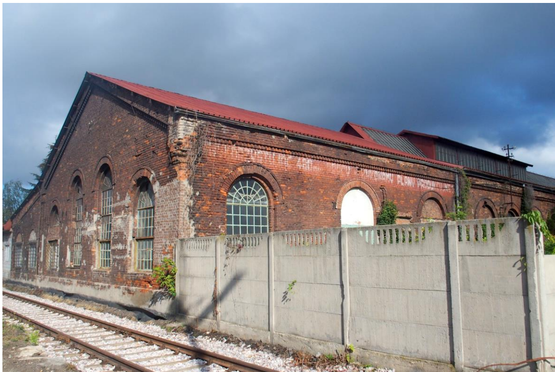
Widok budynku od południa
