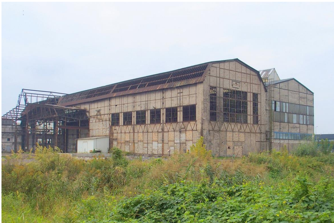
Widok budynku od północno-wschodu
