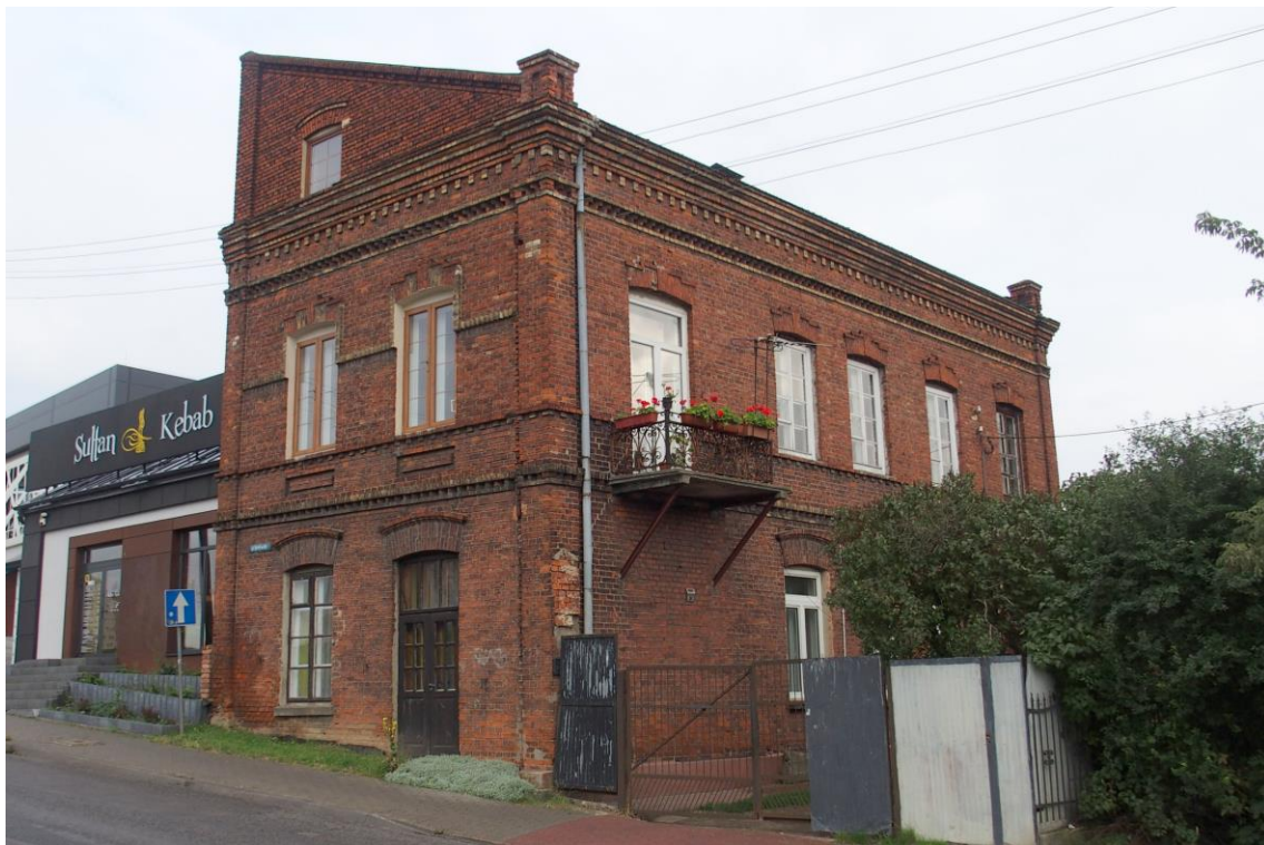
Widok budynku od północno-zachodu
