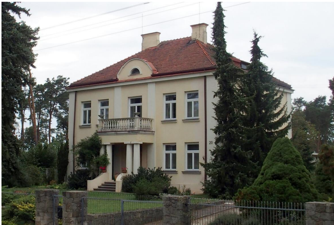
Widok budynku od północno-wschodu
