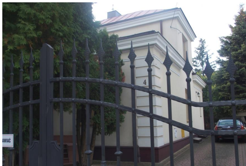
Widok budynku od wschodu
