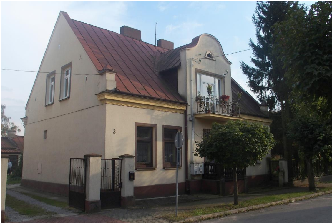
Widok budynku od północno-zachodu
