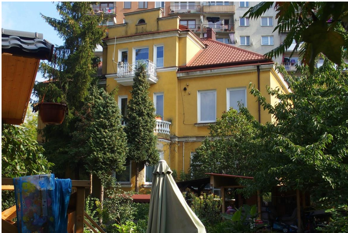
Widok budynku od południowego-zachodu
