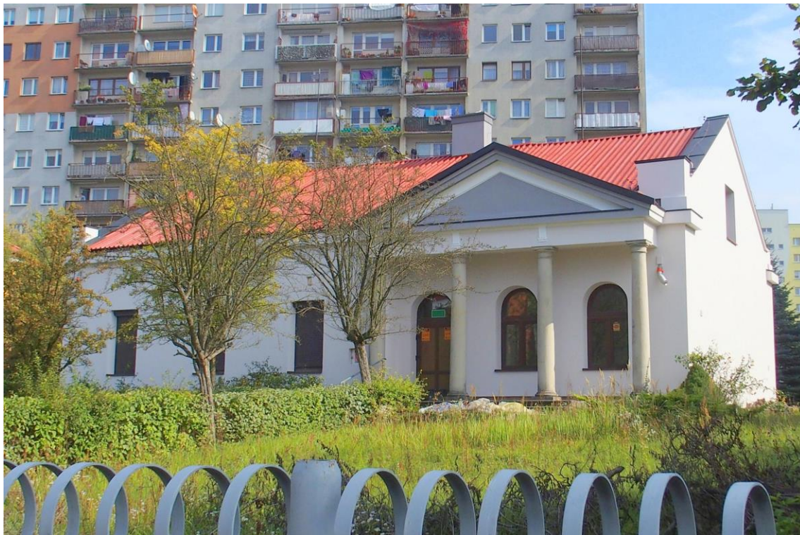
Widok budynku od południowego-zachodu
