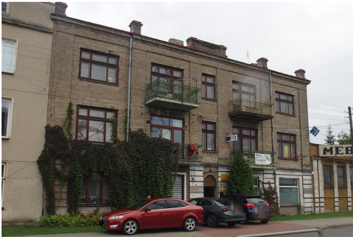
Widok budynku od północno-zachodu
