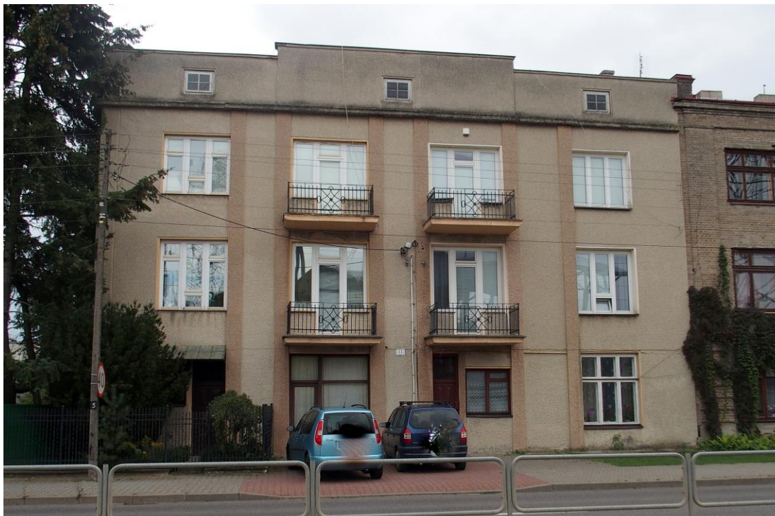
Widok budynku od północno-zachodu
