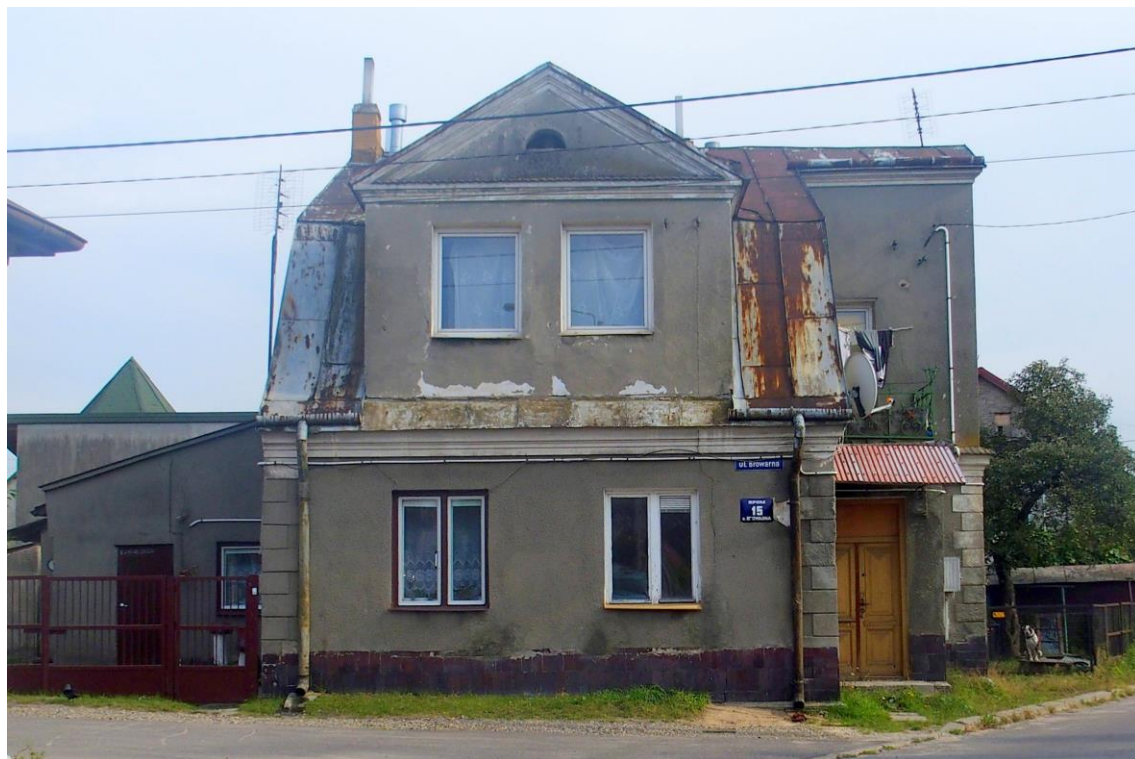
Widok budynku od północno-zachodu
