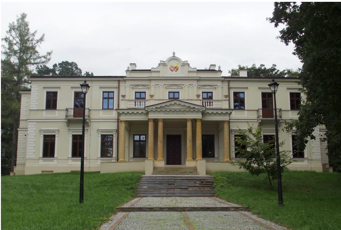
Widok budynku od północy
