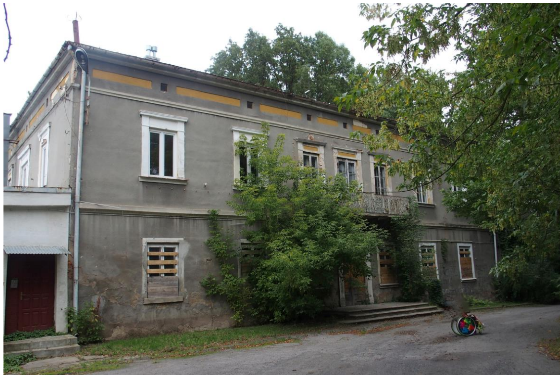
Widok budynku od południowo-zachodu
