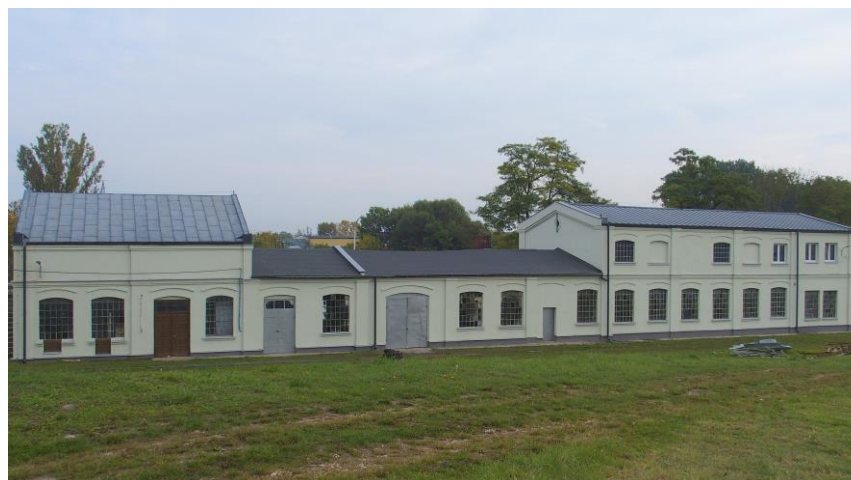
Widok budynku II od południowego-zachodu
