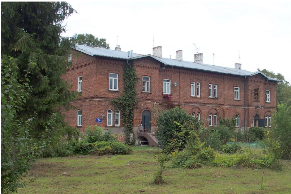
Widok budynku od południowo-zachodu
