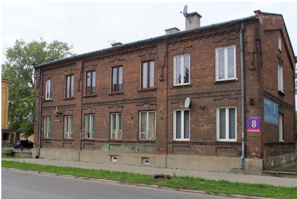
Widok budynku od południowo-wschodu
